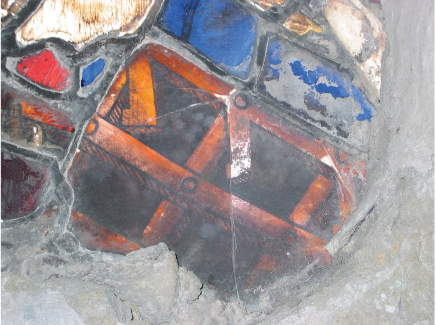
Estat abans de la restauració
